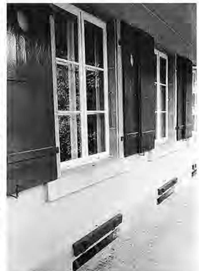
Detail Erdgeschoss: Sandstein, einfach verglaste Fenster mit Vorfenstern
